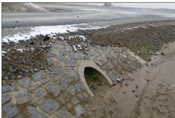
Propustek 6c - staničení 0,011 - pohled zleva
