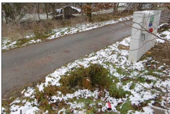
Propustek 2c - staničení 0,100 - pohled zleva
