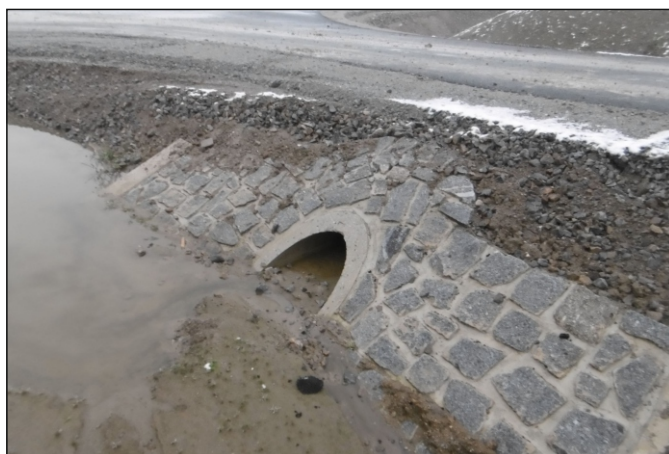
Propustek 6c - staničení 0,011 - pohled zprava
