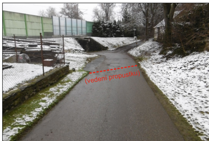
Propustek 1c - staničení 0,769 - celkový pohled
