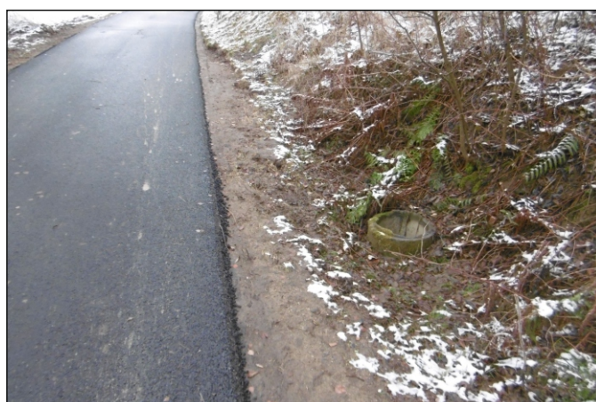
Propustek 1c - staničení 1,215 - pohled zleva
