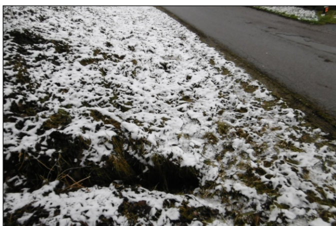
Propustek 1c - staničení 0,769 - pohled zleva
