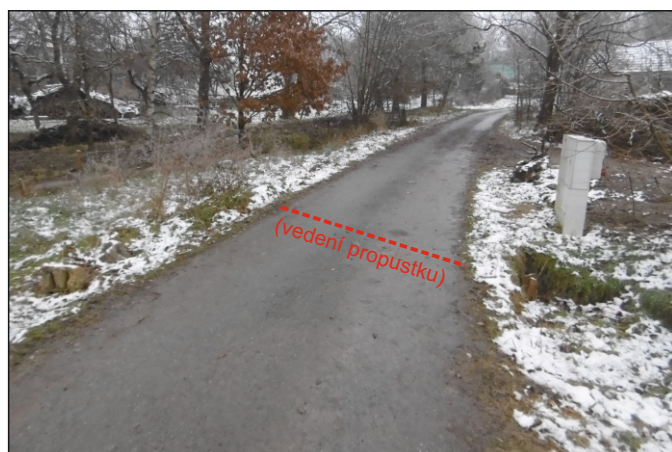
Propustek 2c - staničení 0,100 - celkový pohled
