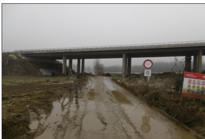
Podjezd 7c-P1 - staničení 0,132 - celkový pohled
