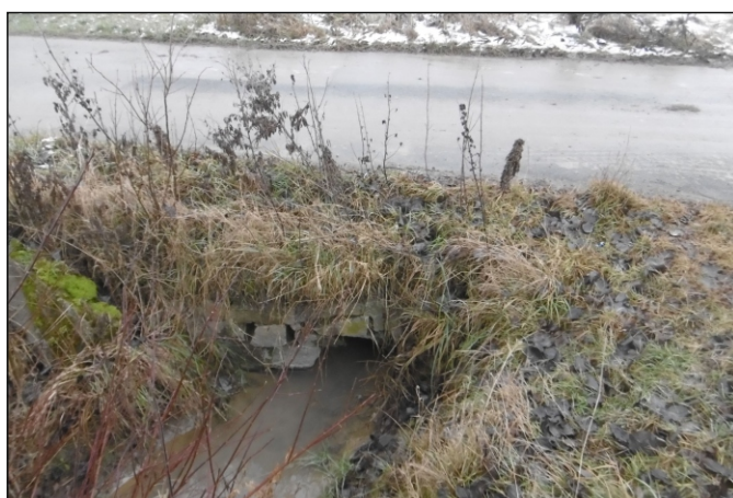
Propustek 7c - staničení 0,458 - pohled zleva
