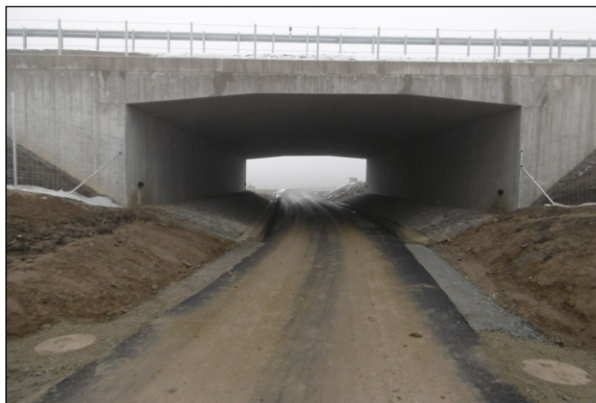
Podjezd 1c-P2 - staničení 1,577 - celkový pohled
