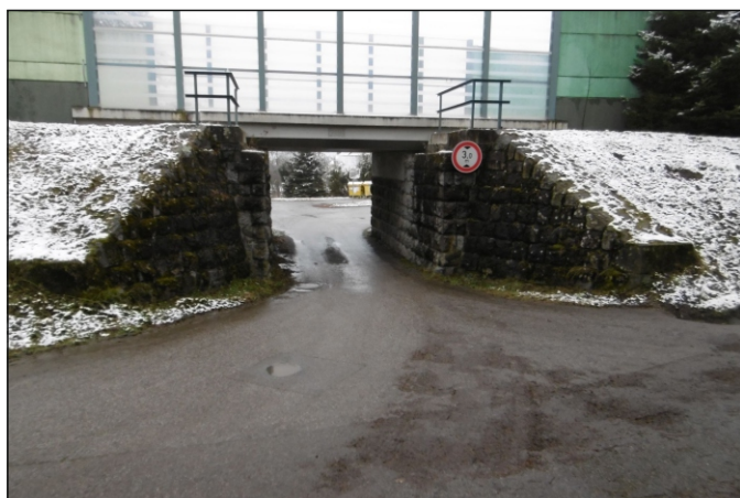
Podjezd 1c-P1 - staničení 0,729 - celkový pohled
