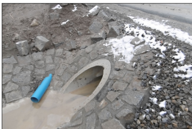
Propustek 1c - staničení 1,623 - pohled zprava
