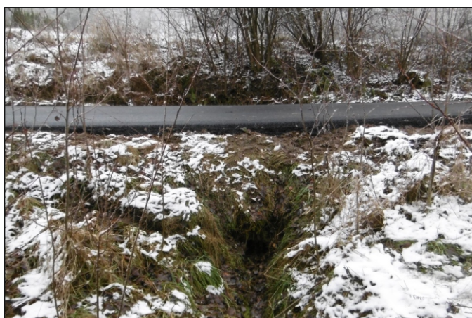
Propustek 1c - staničení 1,215 - pohled zprava
