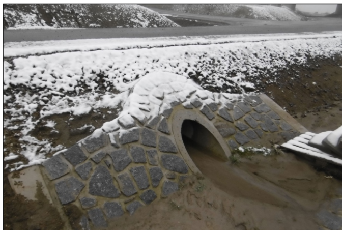
Propustek 1c - staničení 1,508 - pohled zprava
