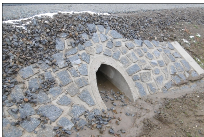
Propustek 1c - staničení 1,508 - pohled zleva
