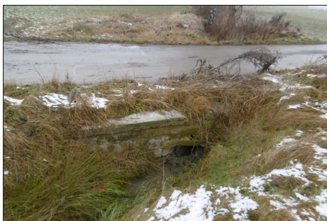
Propustek 7c - staničení 0,458 - pohled zprava
