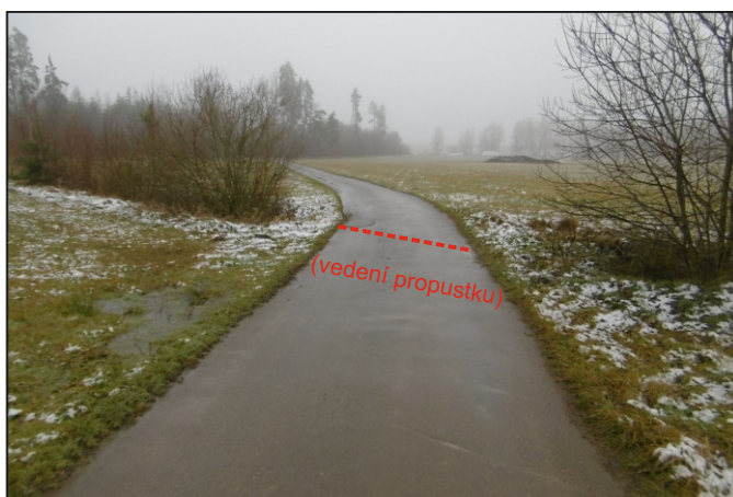
Propustek 7c - staničení 0,793 - celkový pohled
