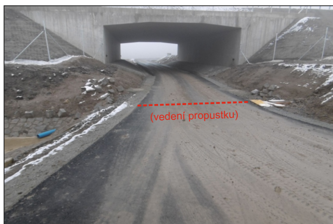
Propustek 1c - staničení 1,623 - celkový pohled
